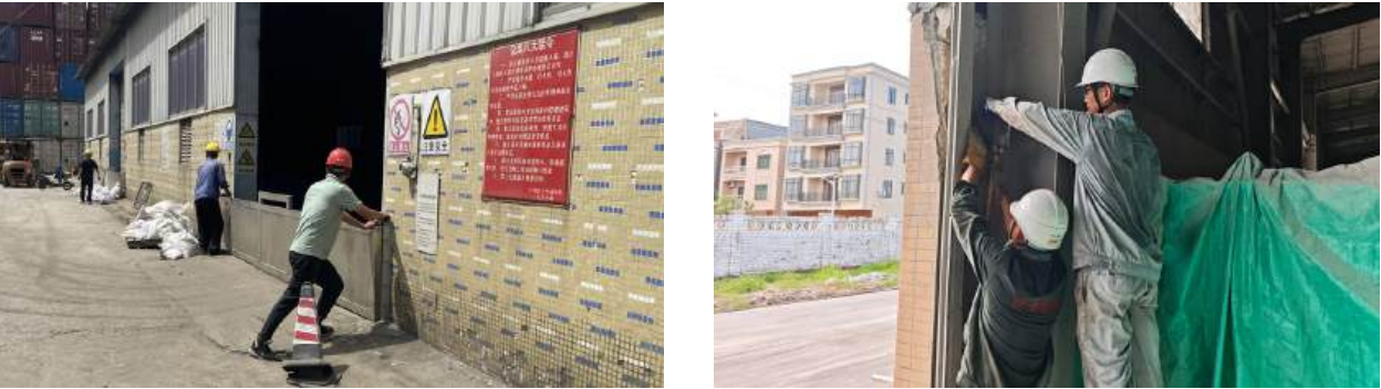
面对超强台风“桦加沙”，开展周密部署、全域排查加固，全力保障人员与物资安全。
