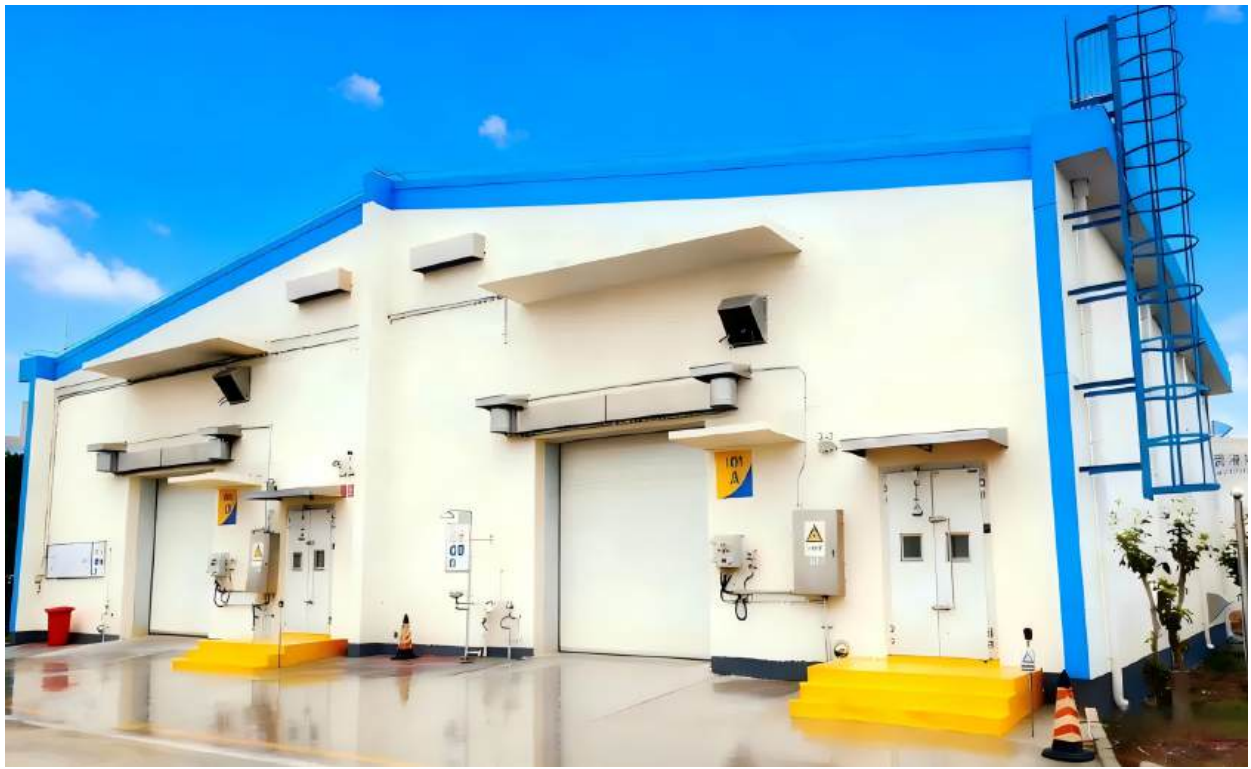
中远海运化工物流自主研发的蒸汽冷凝水回收系统每年使 600 吨水“重新上岗”，同时节约 250 吨蒸汽，相当于减少近 400 吨碳排放；新建船舶水污染物岸上处理场站，每年处理约 3000 吨污水，“生活污水一体化处理”技术让库区内生活污水变废为宝，实现净化回用。
